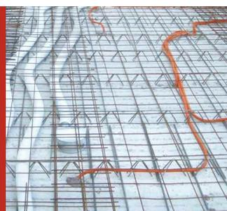
*Gaines de distribution en couronnes FlexPipe® FRS pour une pose simple et rapide.*
