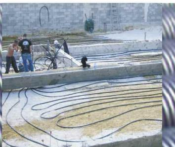
*Pose des capteurs géothermiques d'un puits canadien à eau glycolée.*
