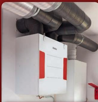
IsoPipe® est une alternative innovante aux conduits spiralés en acier galvanisé calorifugés.
