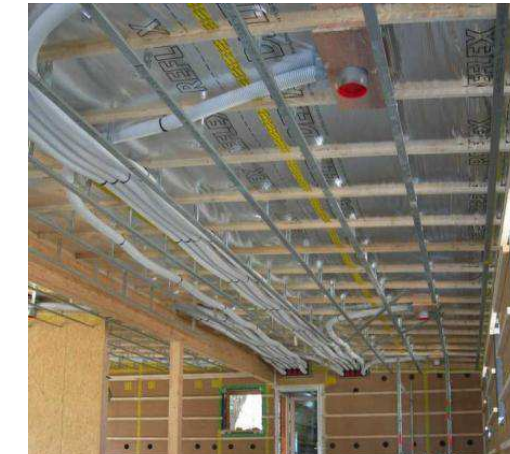
Pose en faux-plafond
