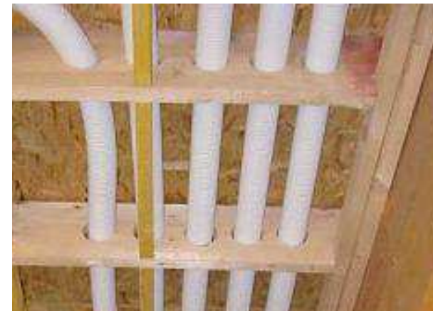
Pose dans l'ossature bois
